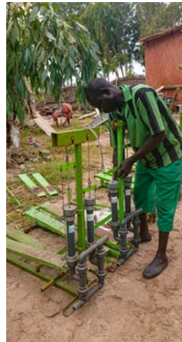
Revision der Pumpen
