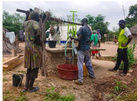
Installation der Pumpe
